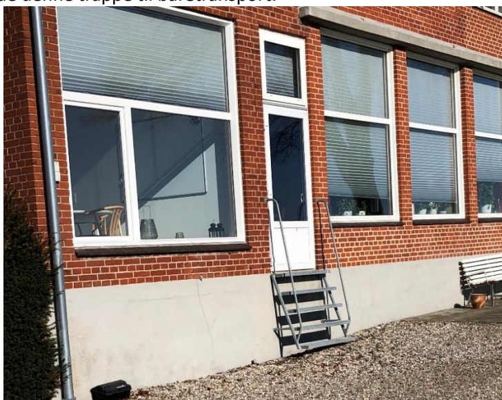
Figur 8 - Flugtvejstrappe der ikke er egnet til båretransport
