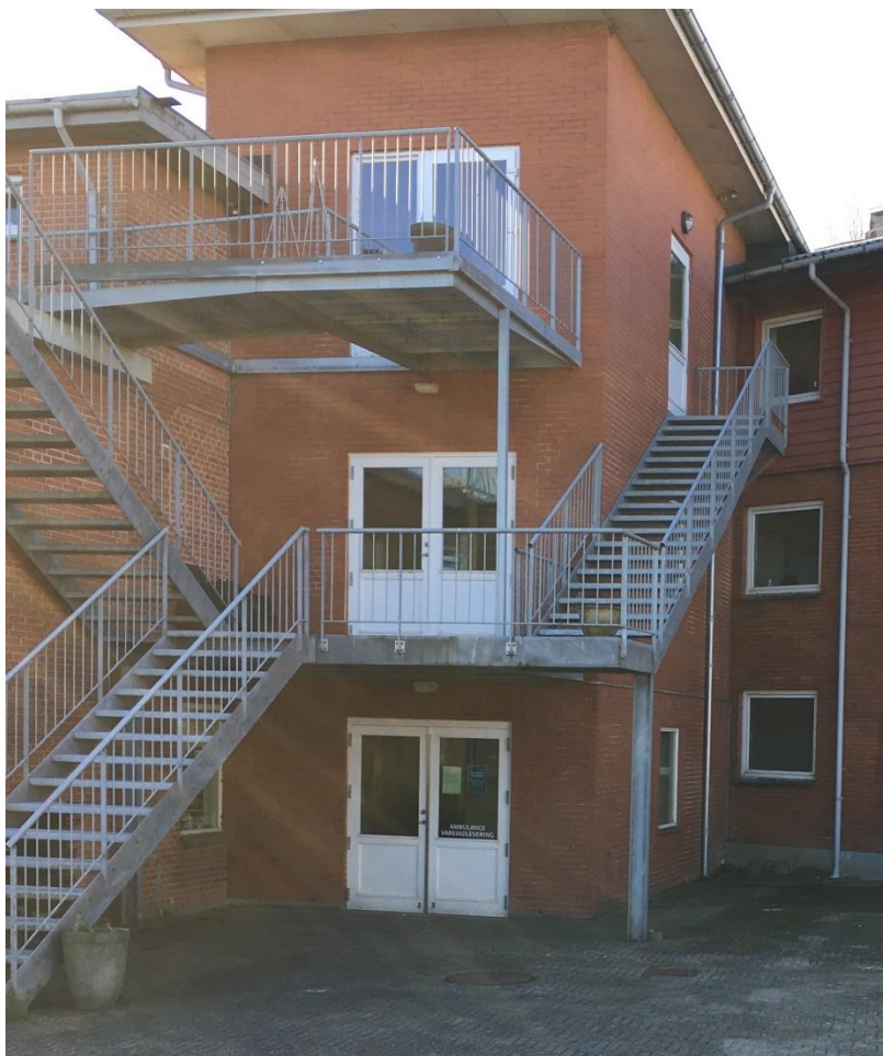
Figur 7 - Altangange og flugtvejstrapper fra 1. og 2. sal, skal indplaceres i enge brandsektioner. Samtidig skal trapperne udføres som bygningsdel klasse R 30 / A2-s1,d0 [BS-bygningsdel 30].
