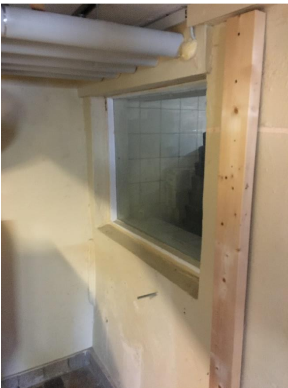
Figur 5: Manglende brandmæssig adskillelse fra depot til teknikrum
