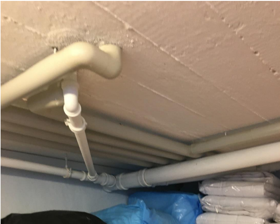
Figur 4: Manglende brandsikring og brandtætning ved faldstammer/afløb udført i plast i kælder.
