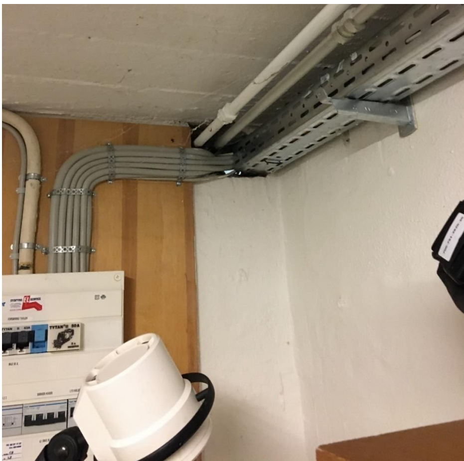
Figur 3: Mangelnde brandtætning ved installationsgennemføring i kælder
